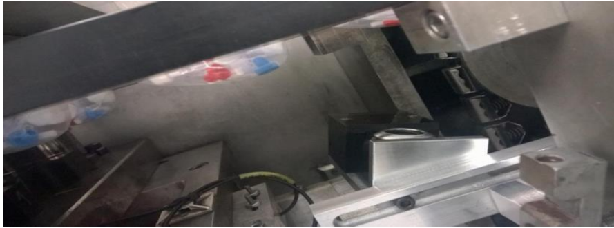
Figura 8. Instalación del sistema de visión
